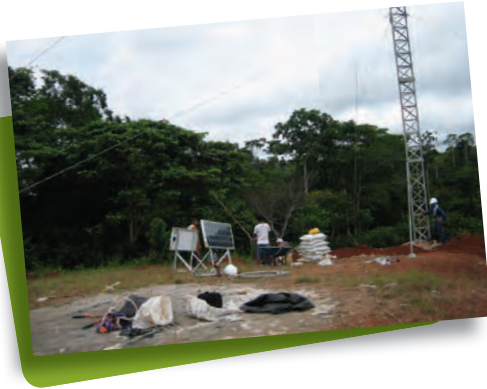
Instalación Plataforma de Equipos de comunicación - Perú
